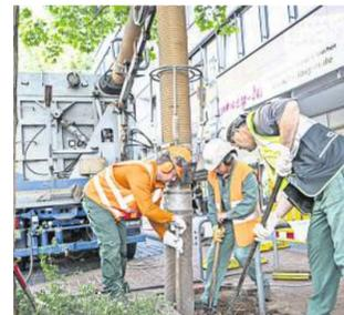
Beim Saugbaggerverfahren werden die Wurzeln des Baums vorsichtig freigelegt – und können im Anschluss begutachtet werden.
